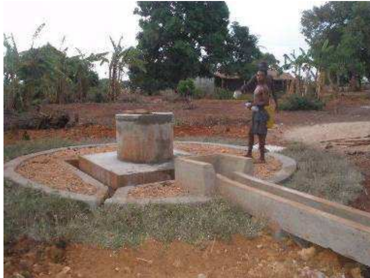
Puit artésien en construction à Ambondro
