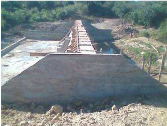
Travaux en cours sur PI Andranomandeha
