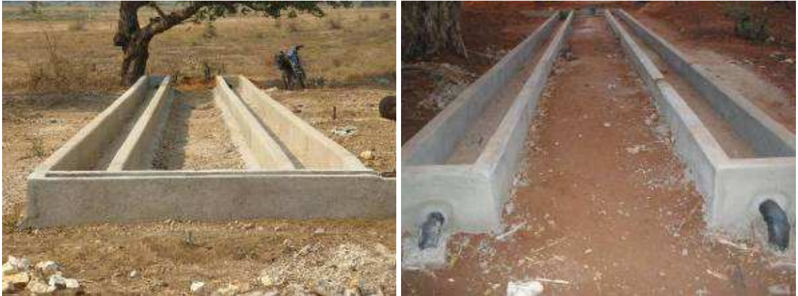
Abreuvoir en construction
