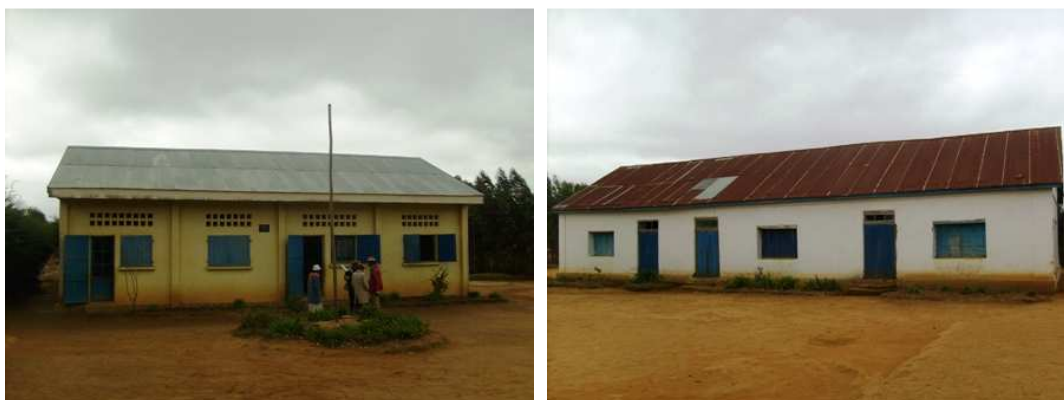
Les deux bâtiments de l'École Primaire Publique d'Amboatavo
