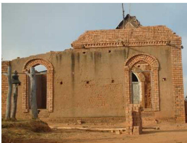
La seule église, sise à Imahatehilaza, en reconstruction depuis 2006
