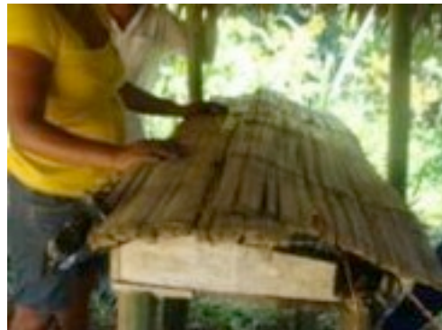
Photo 9 : Ajout de paille de riz sur la couche superficielle, Morisset P., 2012
