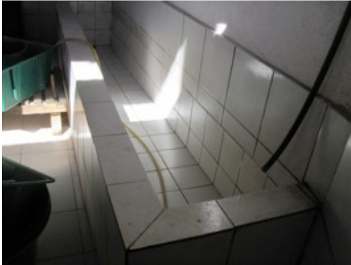
Figure 3 : Bac de lavage de l'usine FOFIFA
