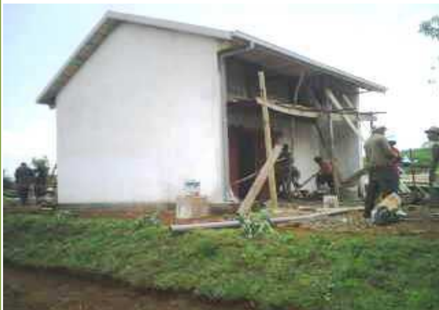
Travaux de construction de GCV de 25 tonnes à Andranomanoa, ITASY
