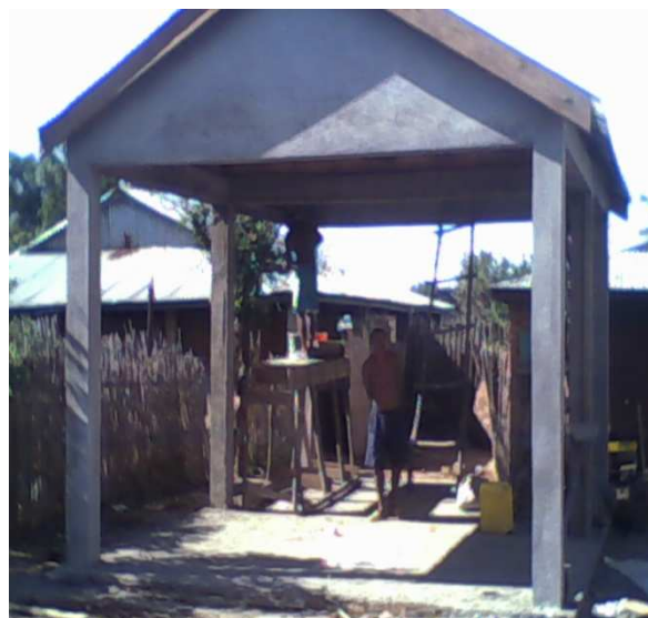
Photo 13: Hangar construit avec l'appui de AD2M
