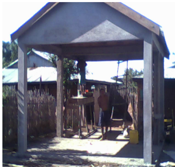
Photo 13: Hangar construit avec l'appui de AD2M
