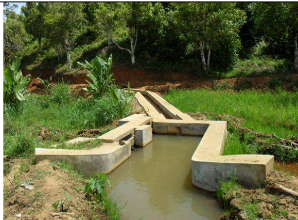
Figure 4 : Régulateur de drain à Sahafamafa, CR Ampasimbe Onibe.
