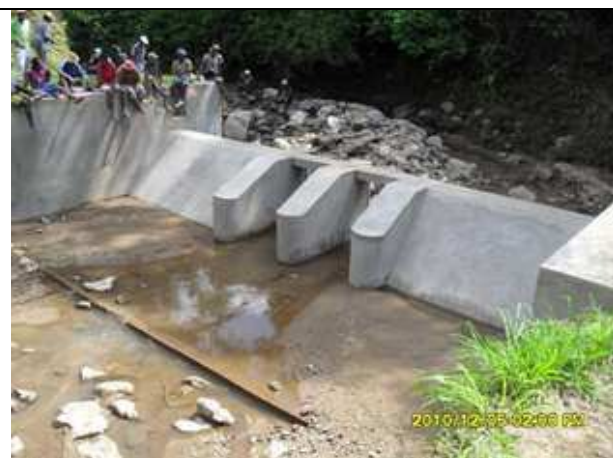
Figure 6 : Barrage nouvellement réhabilitée à Ambohitraivo, ITASY
