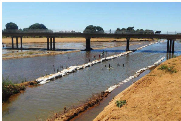
Figure 2 : Renforcement du canal d'adduction d'eau vers Ampijoroana, Mampikony, SOFIA
