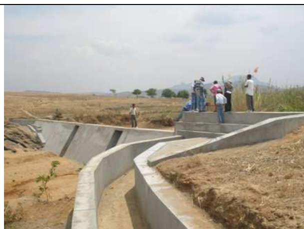
Figure 5 : Barrage de Mahasoa réhabilité dans la Commune Ambinaniroa du District Ambalavao, HAUTE MATSIATRA
