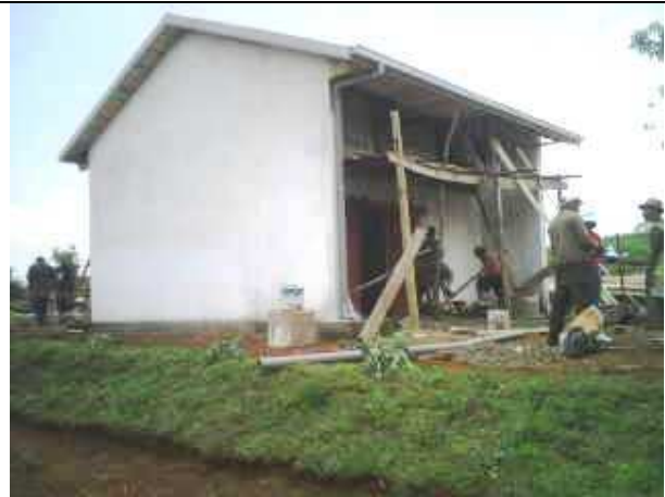
Figure 4 : Travaux de construction de GCV de 25 tonnes à Andranomanoa, ITASY.
