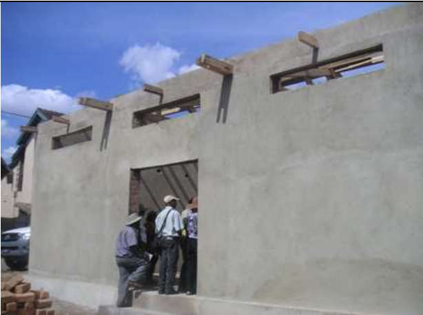
Figure 3 : Avancement des travaux de construction de GCV 50 t à Nasandratrony du District ISANDRA, HAUTE MATSIATRA
