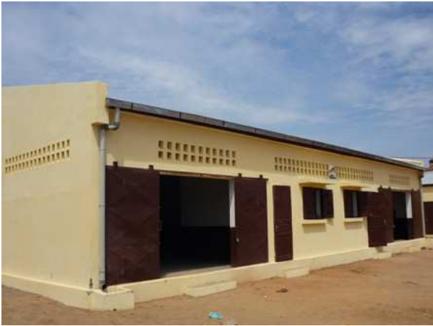
Figure 1 : GCV 50 t à Alatsinainy Bakaro – Andramasina
