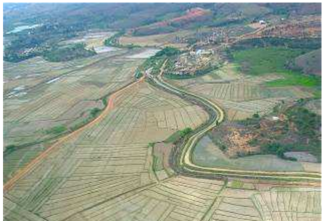
Figure 4 : Région Alaotra - Canal principal rive gauche et drain de protection PI rizicole de la Marianina réhabilités
