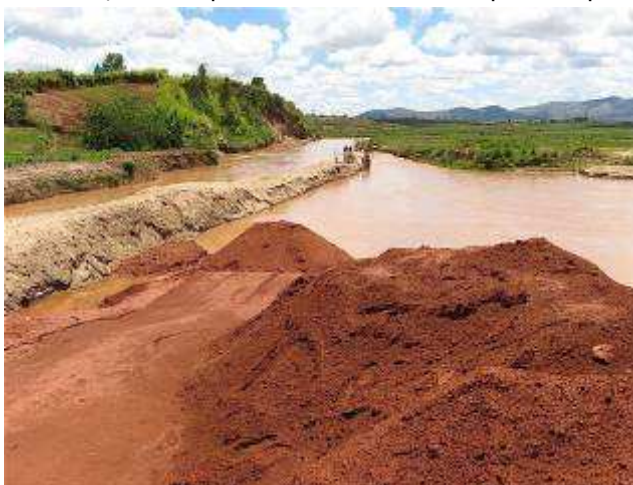
Figure 3 : Région Itasy - Comblement d'une brèche sur la rive gauche de la Varahina, PI d'Antanetibe, Itasy
