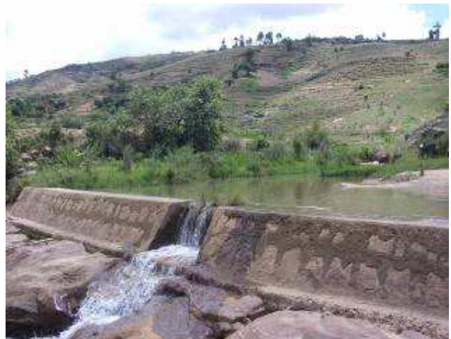
Figure 2 : Région Haute Matsiatra - Seuil du barrage du PI d'Amagna Famoriana à rehausser pour augmenter la superficie irriguable
