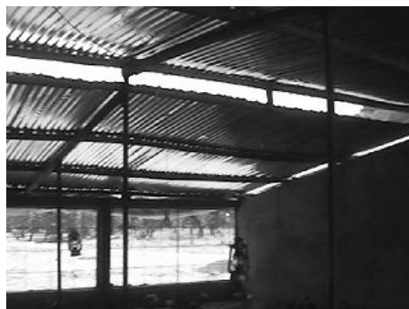
photographie 11 : toit en tôle, bâtiment d'Abdoulaye Dembelé, Sikasso
